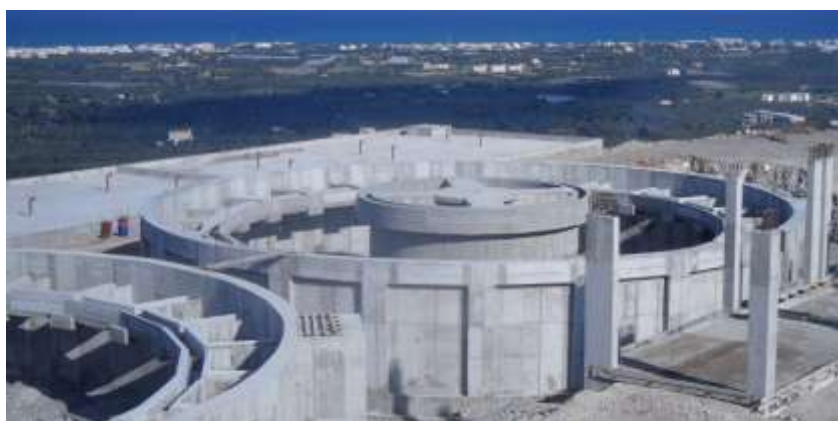
Κατασκευή δεξαμενών καθίζησης - κροκίδωσης
