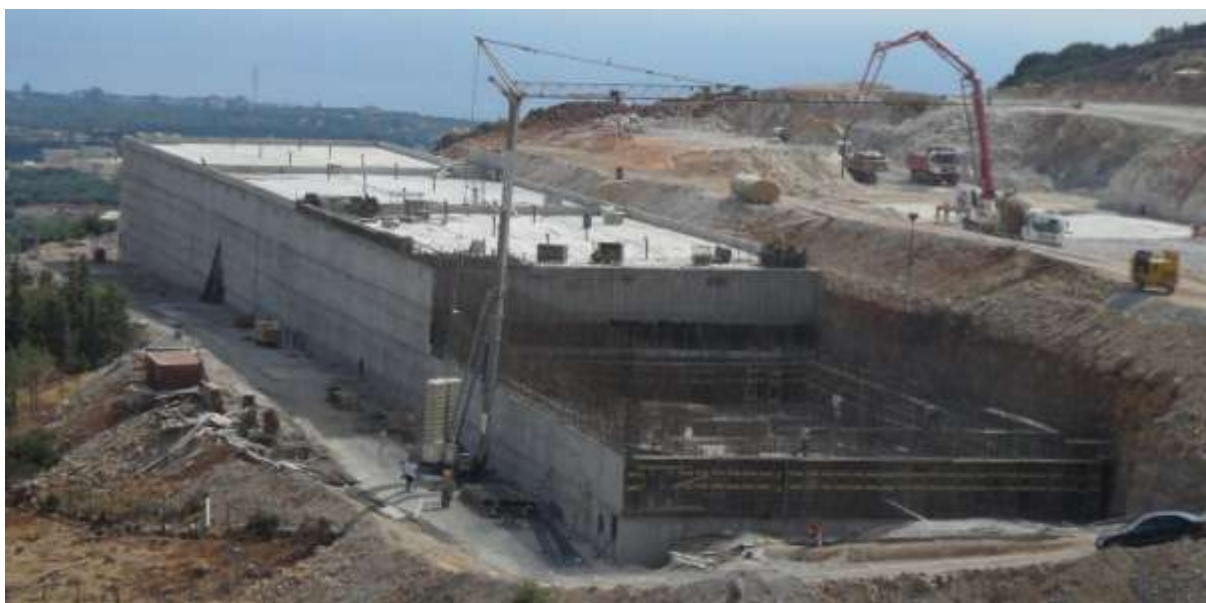
Κατασκευή εγκατάστασης διυλιστηρίου νερού
